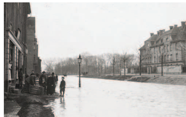
Links die westliche Fahrbahn der Boltensternstraße: Weil sie zwei Meter tiefer lag, wurde sie überflutet.
